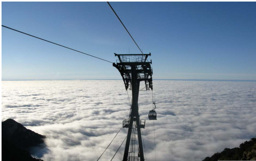
图 14：客运架空索道
