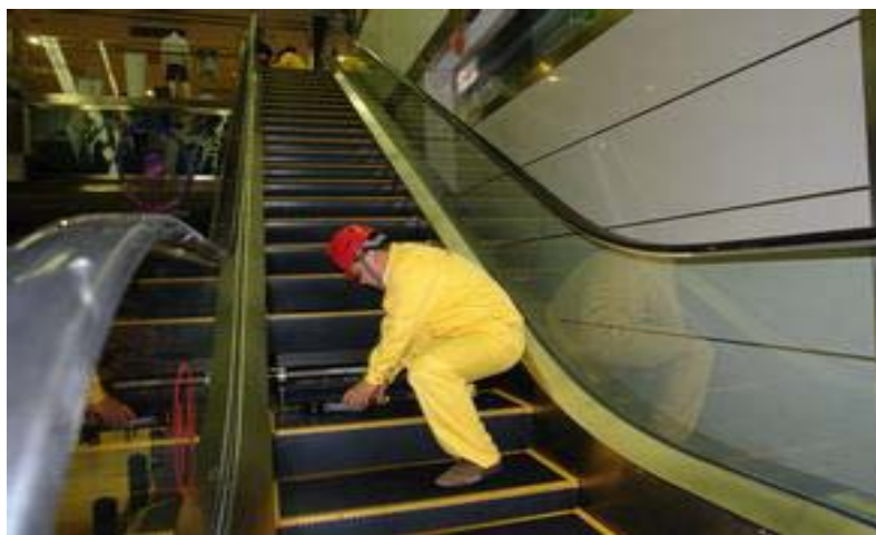
图 22：检验人员在电梯进行检验
