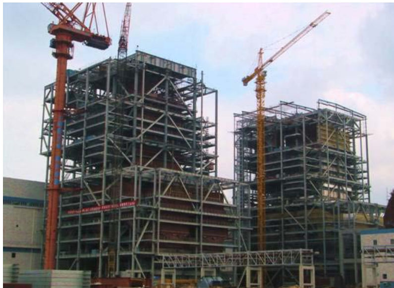
图 5：建设中的电站锅炉
