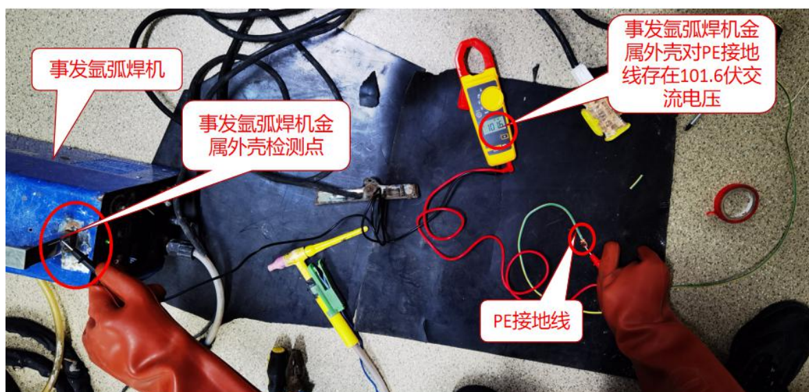
图 19 事发氩弧焊机金属外壳带电检测情况图
